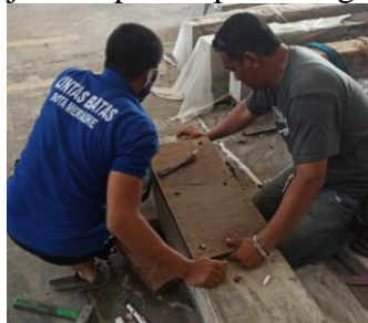
Gambar 4 Proses pemasangan panel mortar geopolimer
