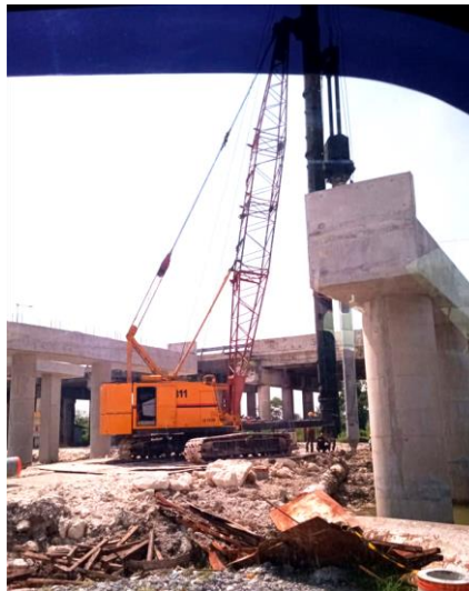
Gambar 2 Pemancangan spun pile menggunakan alat drop hammer
