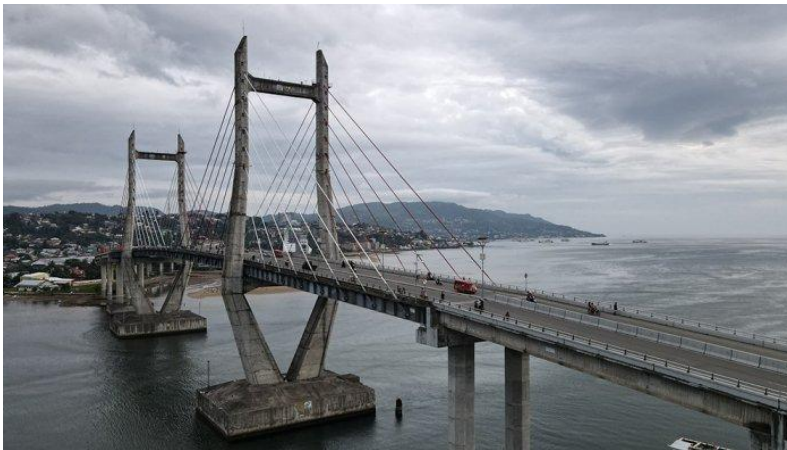
Gambar 1 Jembatan Merah Putih di Kota Ambon
