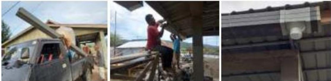
Gambar 6 Proses pengangkutan tandon air, pemasangan talang air, dan talang air yg sudah siap alir ke tandon penyaring
