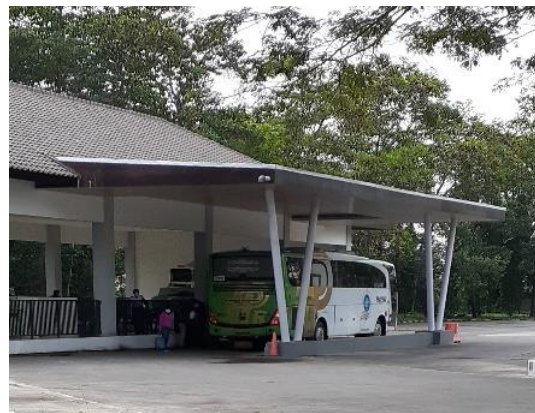
Gambar 4 Kondisi Eksisting Jalur Kedatangan
