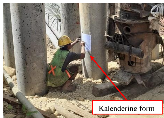
Gambar 3 Pengukuran total deformasi penetrasi tiang dan final set HCP3.2
