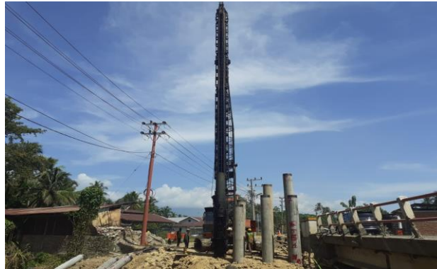
Gambar 2 Pemancangan Driven Precast Concrete Pile f_c' 30 MPa, HCP3.2.
