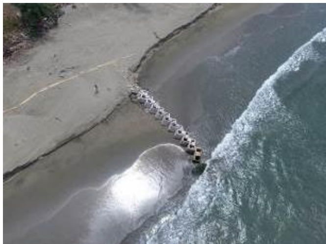
Gambar 6 Lokasi setelah pemasangan gropozag
