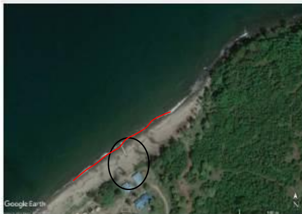
Gambar 11 Kondisi garis pantai awal pemasangan gropozag tahun 2018
