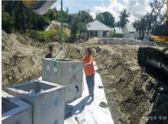
Gambar 5 Pemasangan/perangkaian unit gropozag pada lokasi
