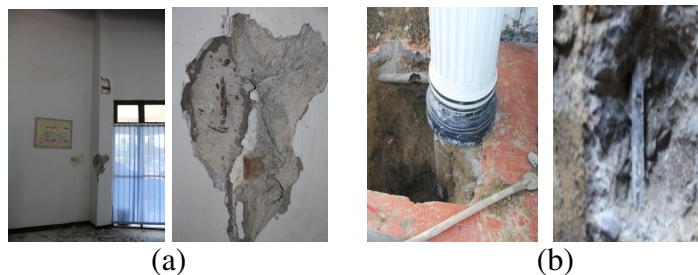
Gambar 9 (a) Pembobokan pada Kolom E'-1 (kondisi rusak), (b) Pembobokan pada Pondasi Kolom A-5 (kondisi utuh)
