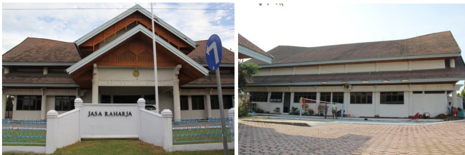
Gambar 2 Tampak depan dan belakang gedung kantor PT. Jasa Raharja (persero) Perwakilan Lhokseumawe
