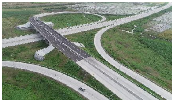
Gambar 1 Jalan tol Pemalang-Batang ( http://pbtr.co.id/v2/galeri , 2020)
