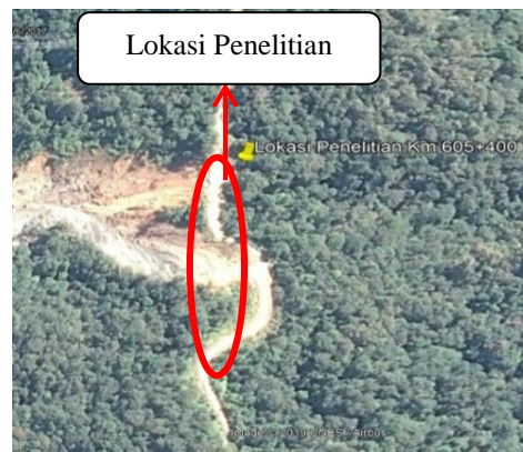
Gambar 2 Kondisi penurunan badan jalan pada lokasi penelitian
