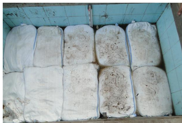
Gambar 4 Tampak atas hasil pemasangan matras
