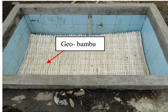
Gambar 2 Peletakan geo-bambu di atas tiang tiang bambu
