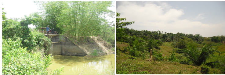
Gambar 5 Kondisi Pintu dan Tampungan Embung Urong Kayee Mirah
