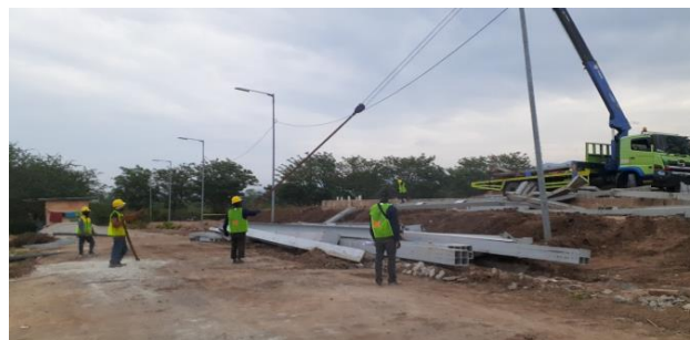
Gambar 1 Pekerjaan Pemasangan Tiang Baja
