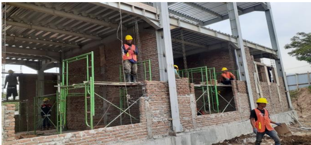
Gambar 2 Pekerjaan Dinding Bata
