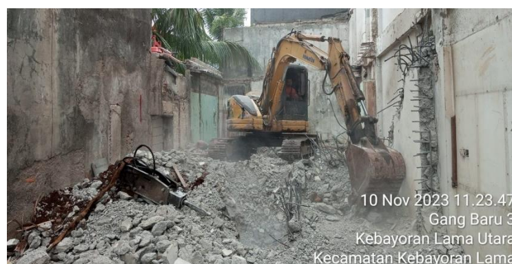
Gambar 7. Metode pembongkaran top-down dengan mesin
