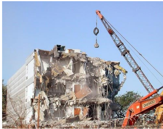
Gambar 8 Metode pembongkaran wrecking ball
