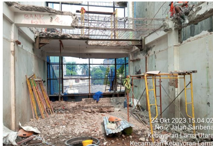
Gambar 6 Metode pembongkaran top-down manual
