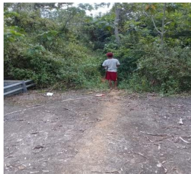
Gambar 4 Kondisi jalan setelah jembatan
