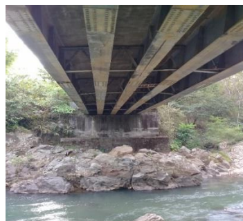
Gambar 5 Kondisi bangunan bawah jembatan
